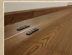
電源を使用しやすいカウンター上と足元に配置
